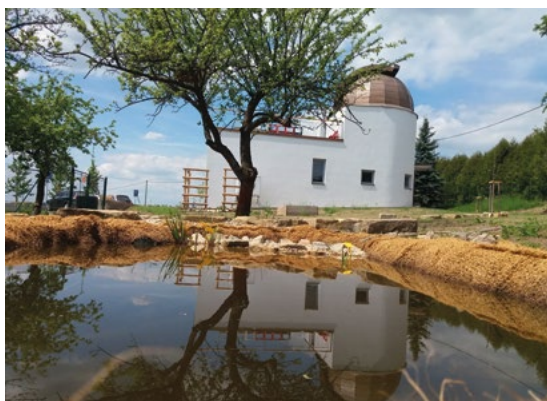
Obr. 1 Centrum přírodních věd – Hvězdárna Jičín vzniklo v roce 2016 kompletní rekonstrukcí původní hvězdárny (z roku 1965).
